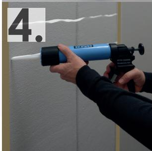
Die zugeschnittenen Platten zur Prüfung an die Wand halten und im Anschluss Silikon streifenförmig und horizontal auftragen, sowie mittig zur Stoßkante doppelseitiges Klebeband aufkleben.
