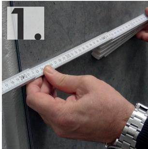
Ihr Montagebereich sollte möglichst eben, tragfähig und trocken sein. Nehmen Sie beim Überprüfen direkt alle relevanten Maße und übertragen Sie diese für den Zuschnitt auf die Platten.
