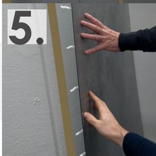
Wenn alles passt, kann nun die Schutzfolie des Klebebands entfernt werden. Die Aufbringung der Wand sollte zügig nachdem das Silikon aufgetragen wurde erfolgen!
