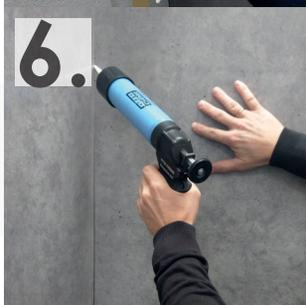
Zu guter Letzt die Platten an der Wand befestigen und die Fugen mit Silikon gegen eindringende Feuchtigkeit abdichten.
